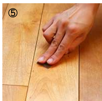
⑤凹み直ったら、仕上げにもう一回サンドペーパーをかけます。
