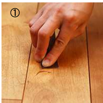
①凹み傷がある部分の周辺だけ、床の表面をサンドペーパーで少し削り、木に水がしみ込みやすくします。
