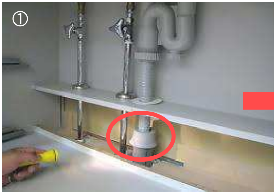
①引き出しをはずして、カバーを取る。
