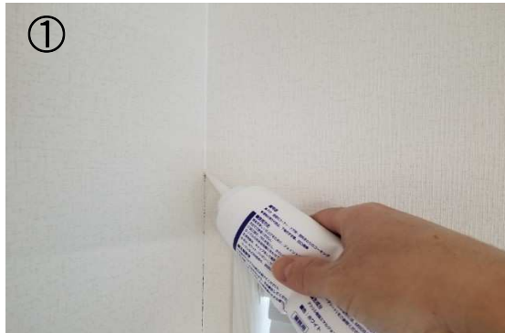
①壁と壁のスキマにジョイントコークで埋める。
