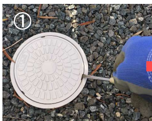
①3ヶ所ある溝の1ヶ所にマイナスドライバーを差し込む。
