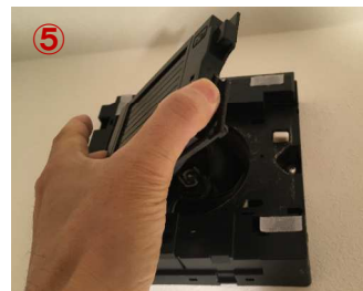
⑤シャッターを取り外す。
