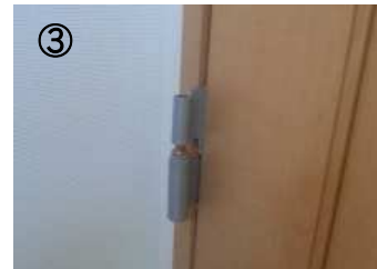
③ 軸キャップを外します。
