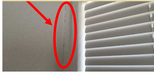
「壁と壁」の間(入隅)
