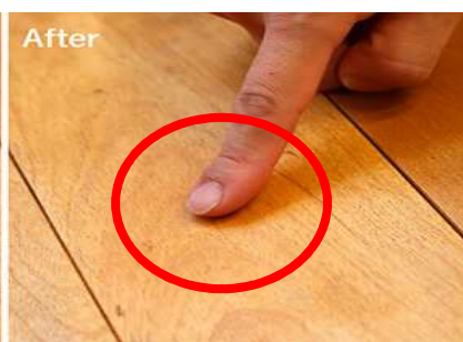
⑤凹み直ったら、仕上げにもう一回サンドペーパーをかけます。
