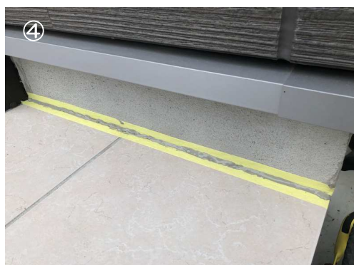
④床用ひび補修材を埋める。
