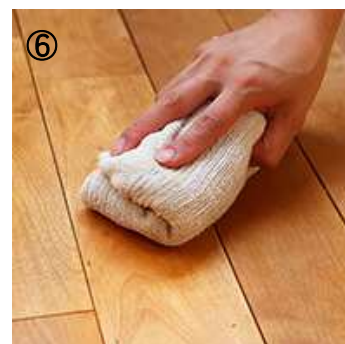
⑥傷の手当をした部分が、白く見える時は、蜜蝋(みつろう)ワックスを塗り込み仕上げましょう。
