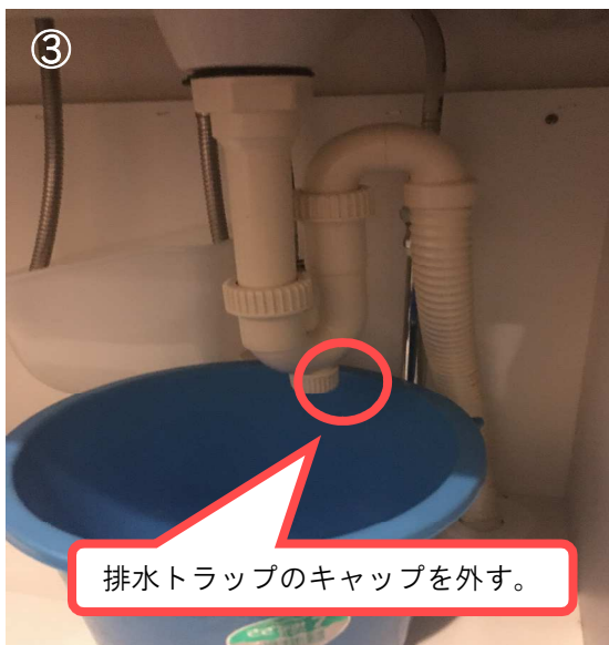
③バケツを用意して排水トラップのキャップを外す。
