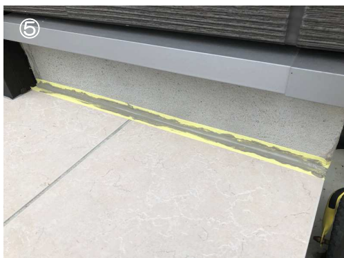
⑤補修材をコテやヘラ等で押し込む。
