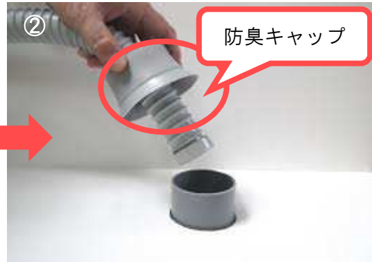
②防臭キャップにスキマがないか確認。
