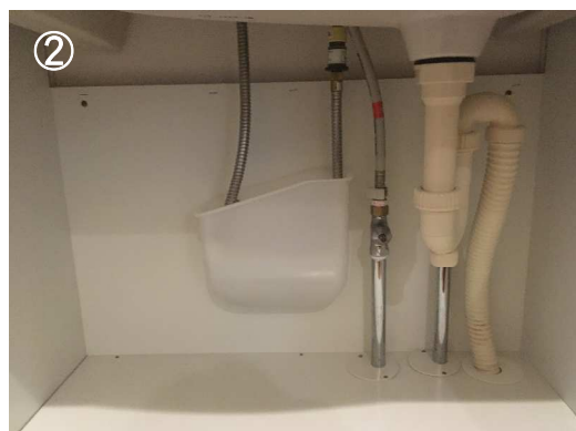
②下のビスを外して防臭キャップを確認。
